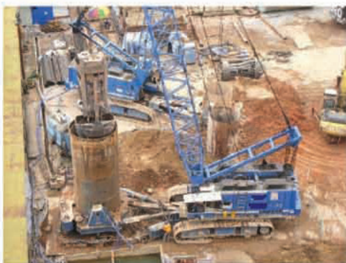
▲ 輕軌工程將使用的鑽孔灌注樁
