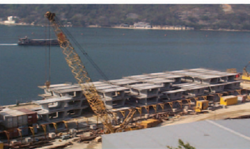
▲ 預製件製造場(外地例子)
