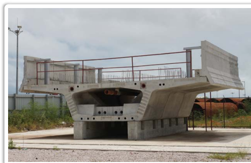
▲高架橋預製件樣本作測試平台
