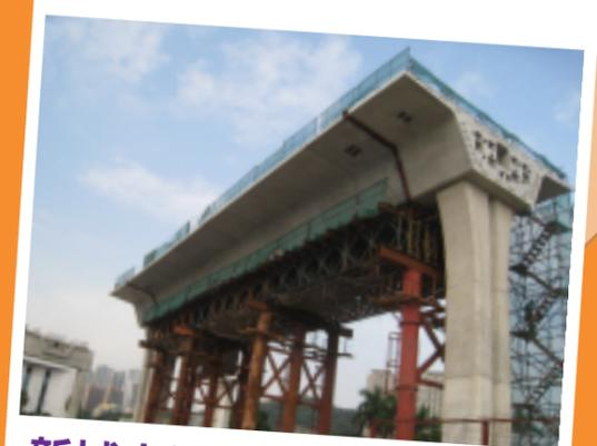
新城大馬路正進行桁架式吊裝高架橋面
