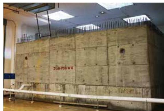
▲設3米高臨時擋水牆及抽水系統應對地下湧水
