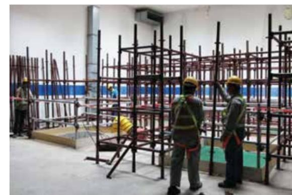
▲施工人員於地下停車場加緊組裝承托樁機的支撐架
