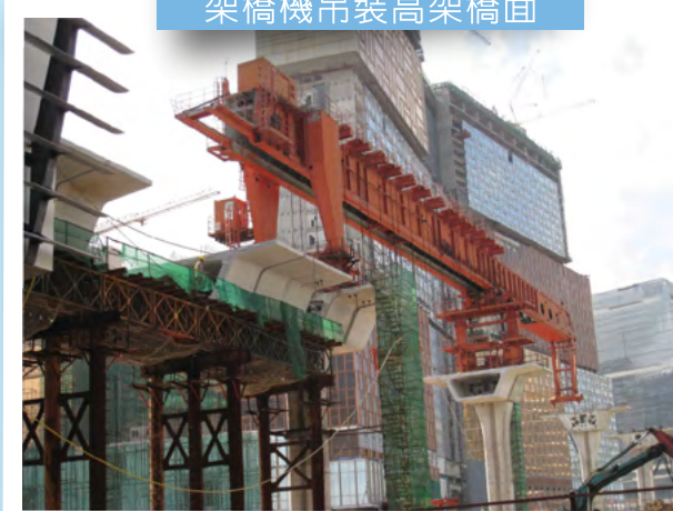
體育館大馬路採用大型 架橋機吊裝高架橋面
