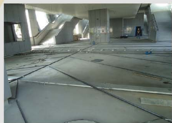
氹仔碼頭站的票務層正進行內部裝修
