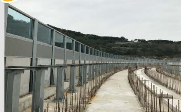
偉龍馬路的隔音屏障已完成安裝
