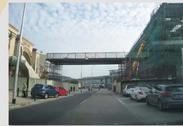
蓮花口岸站正在安裝行人天橋
