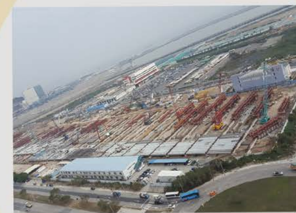
輕軌車廠上蓋工程正在建設樓板
