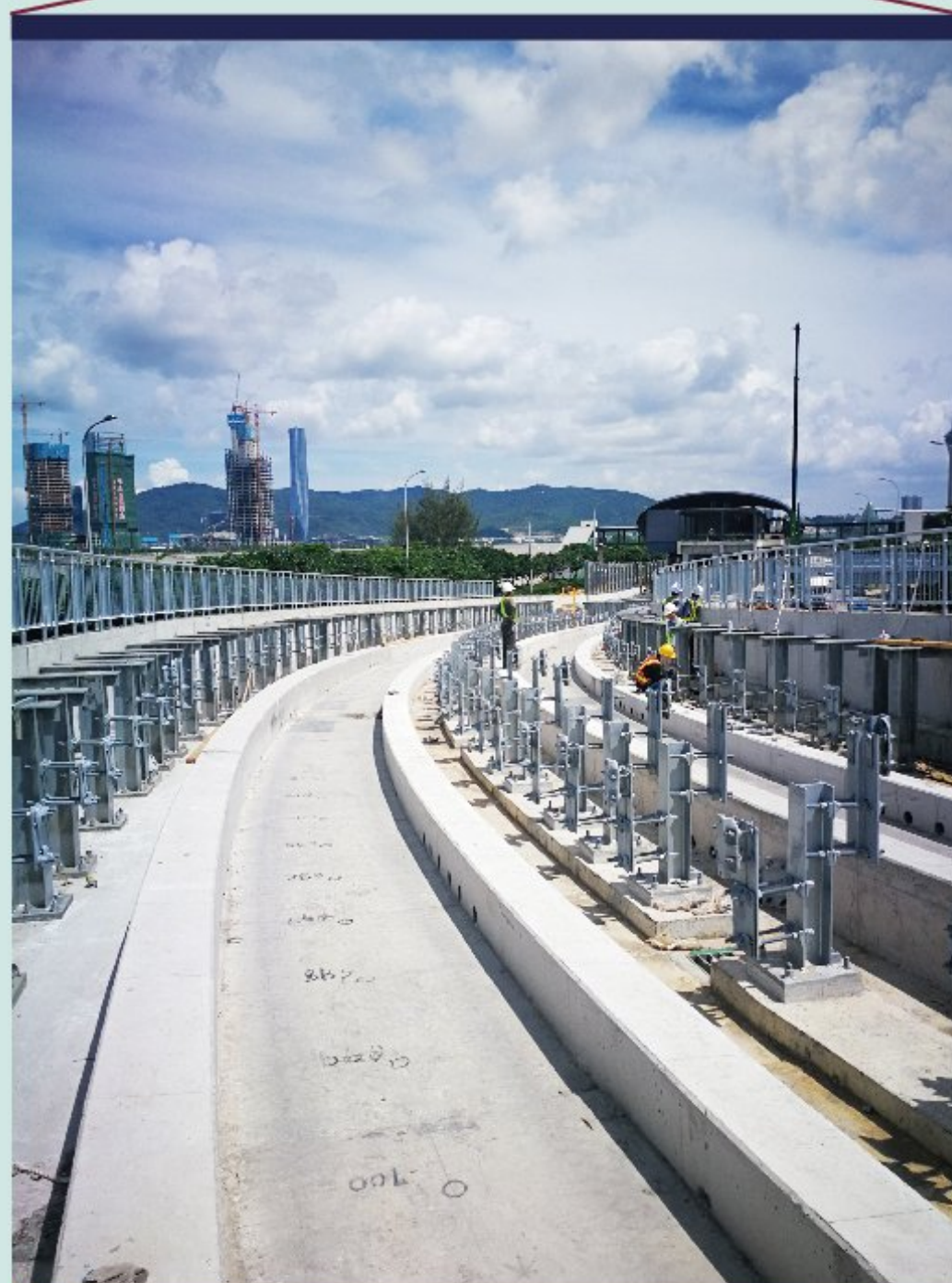
東亞運大馬路橋面正在進行列車系統安裝工作
