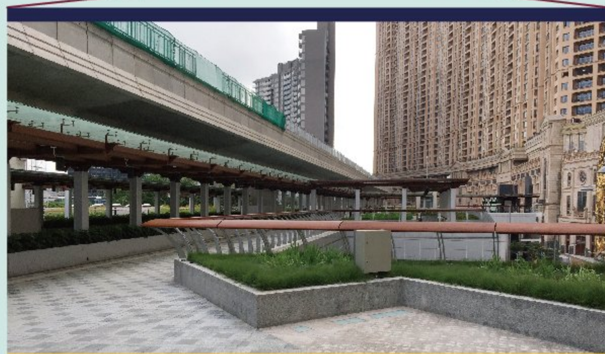
氹仔柯維納馬路交通樞紐平台建設實況
