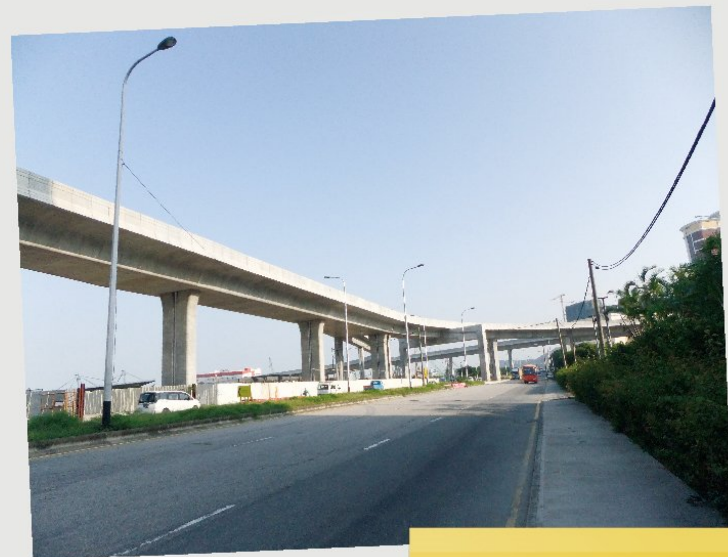
已連成一線的高架橋
