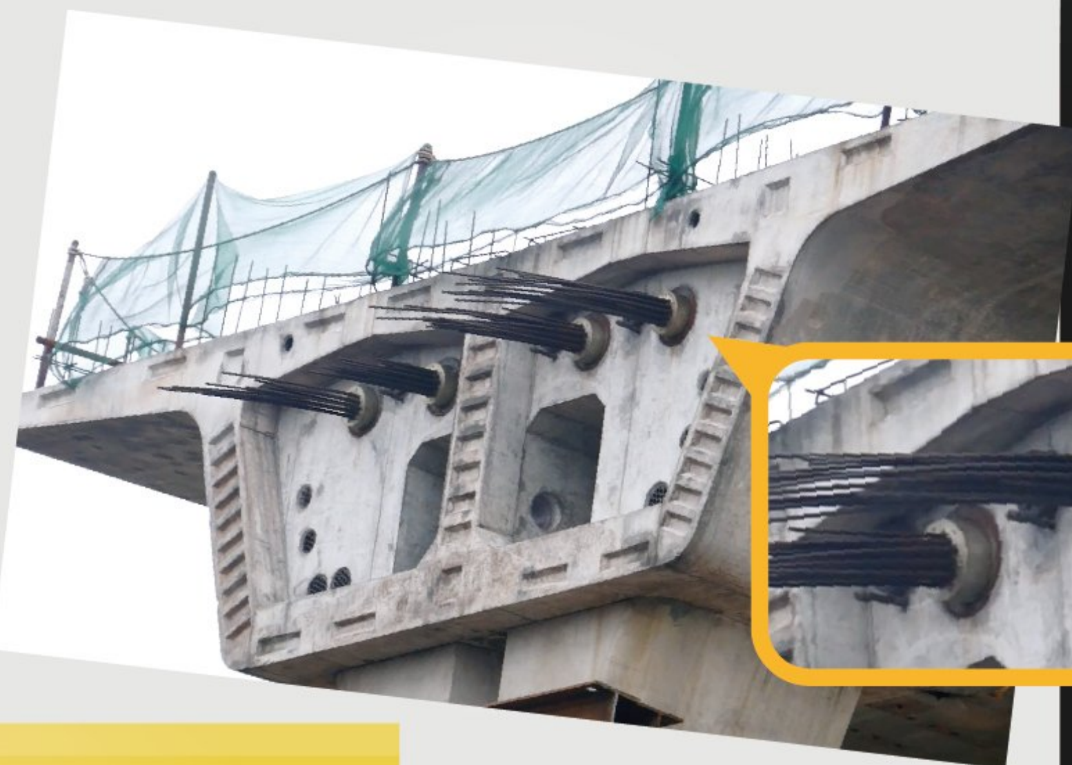
預應力鋼纜的安裝位置
