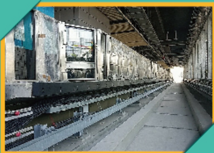
● 海洋站內已經完成幕門安裝
