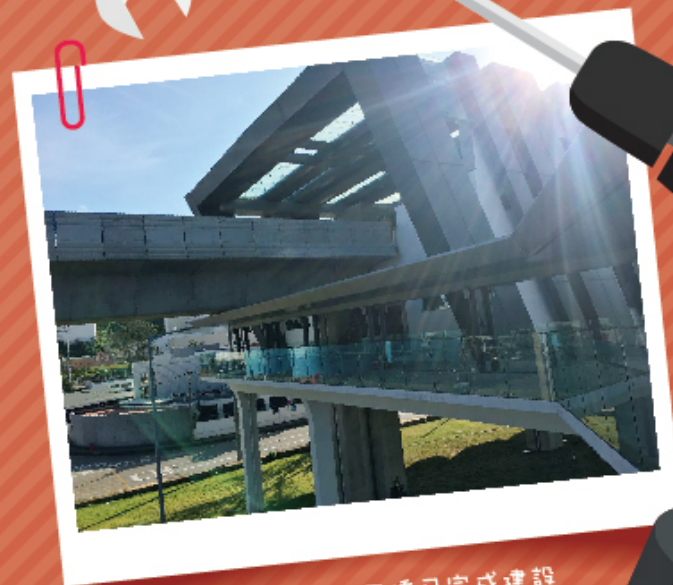
沙仔碼頭站的行人天橋已完成建設
