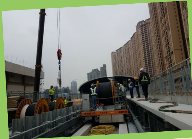
工作人員於柯維納馬路安裝管線情況
