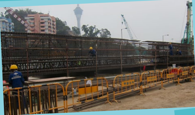
媽閣站開展地下連續牆施工工序
