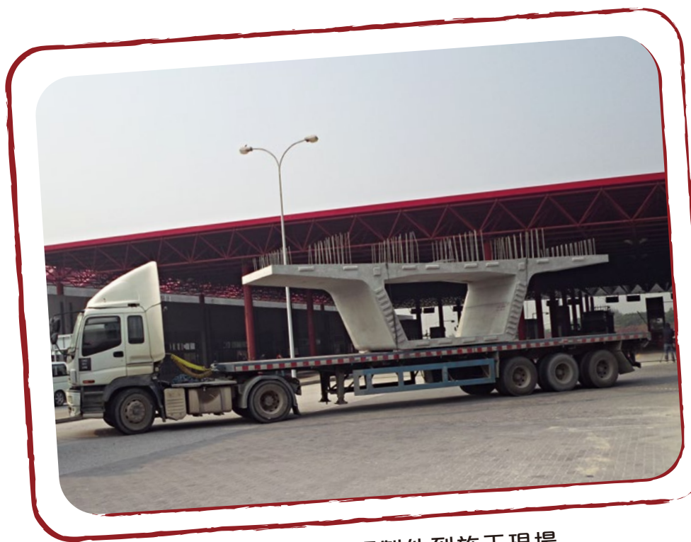
運送輕軌高架橋預製件到施工現場
