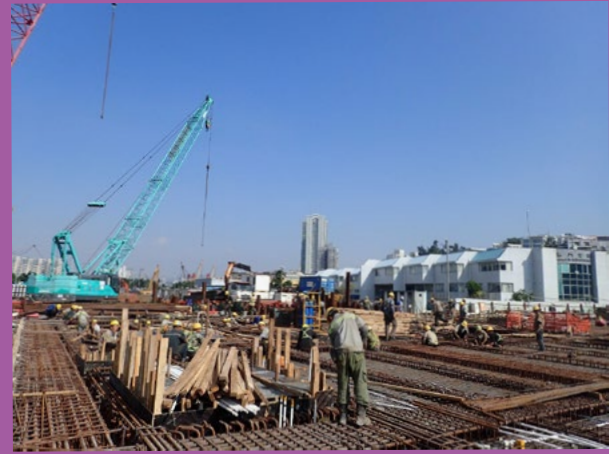
媽閣交通樞紐地面層結構施工實況
