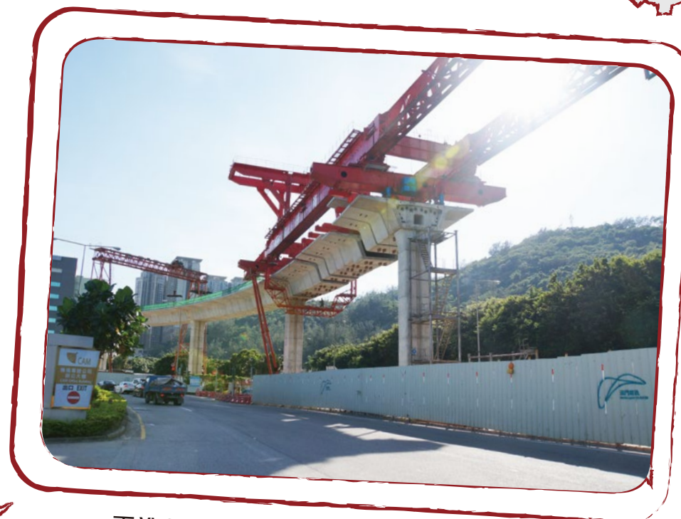
正進行輕軌高架橋橋面預製件吊裝工作
