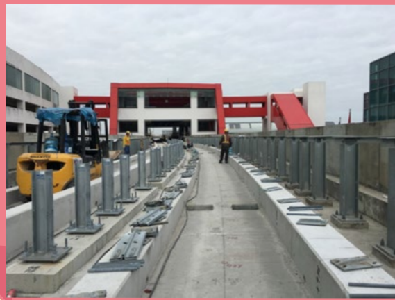
機場站對出高架橋已完成行車基座施工
