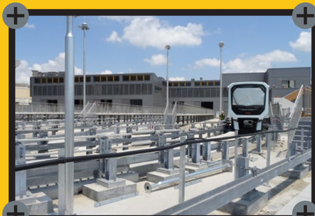
部分列車車廂已運抵車廠並陸續開展 各項列車檢測工作
