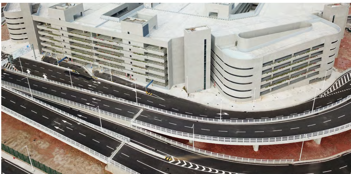
港珠澳大橋口岸及周邊交通配套設施
