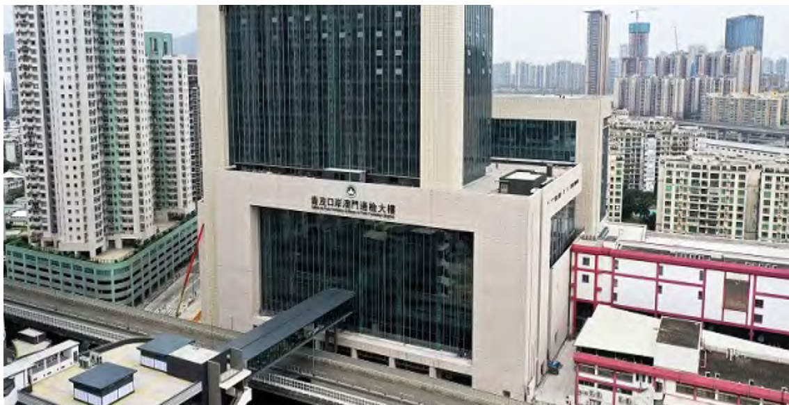
青茂口岸及周邊交通配套設施
