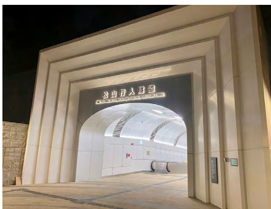
松山行人隧道
