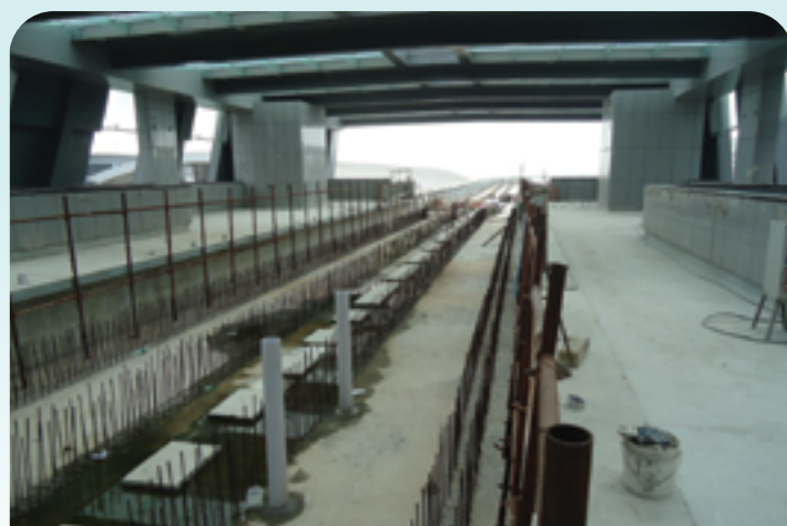
沙仔碼頭站月台層正進行內部裝修
