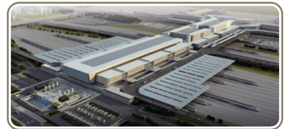
虹橋綜合交通樞紐核心建築
