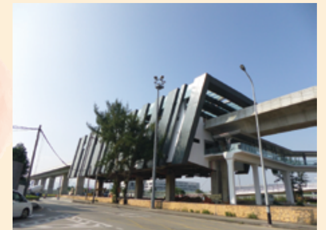
▲車站已完成結構施工
