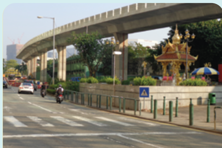
柯維納馬路一段高架橋已完成護牆的吊裝工序
