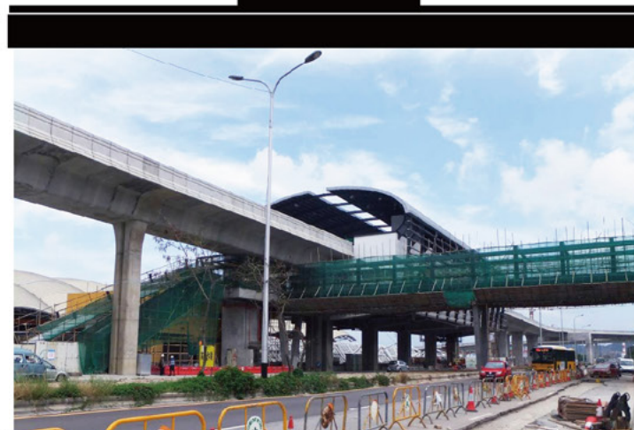
科大站行人天橋建設大致完成
