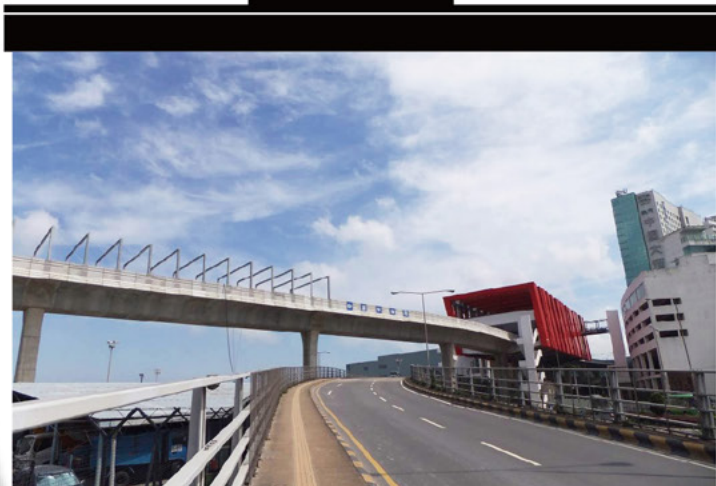
機場站一帶的高架橋正安裝全圍封屏障的鋼結構
