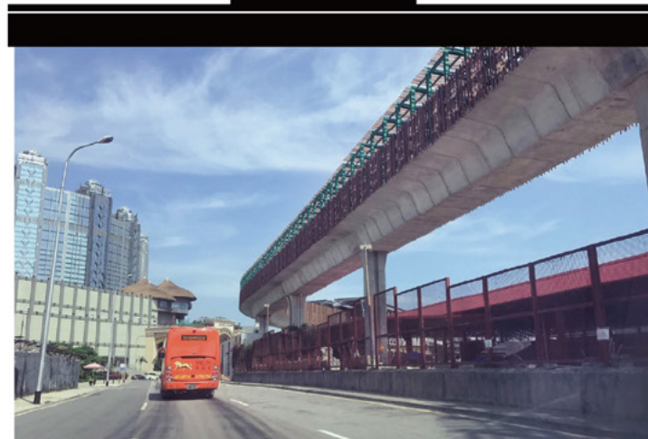
蓮花口岸站的視覺屏障安裝基本完成
