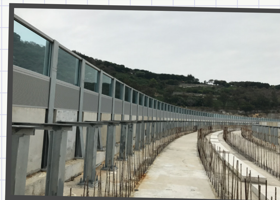
▲ 隔音屏障可減低日後列車運作的潛在影響
