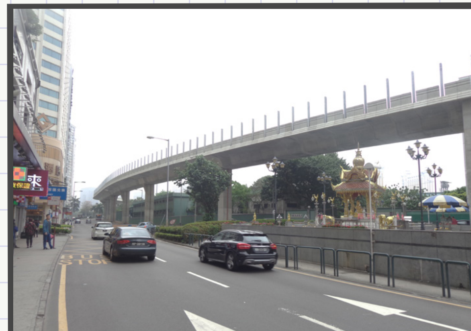
▲ 柯維納馬路正在構建隔音屏障
