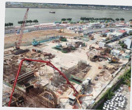
媽閣交通樞紐地面層結構已基本完成
