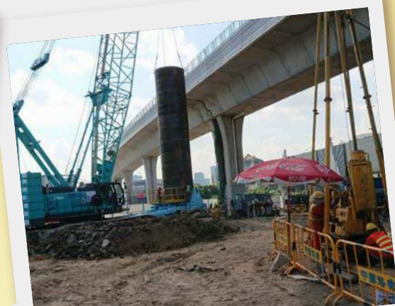
蓮花圓形地內正進行輕軌 石排灣線樁基礎施工
