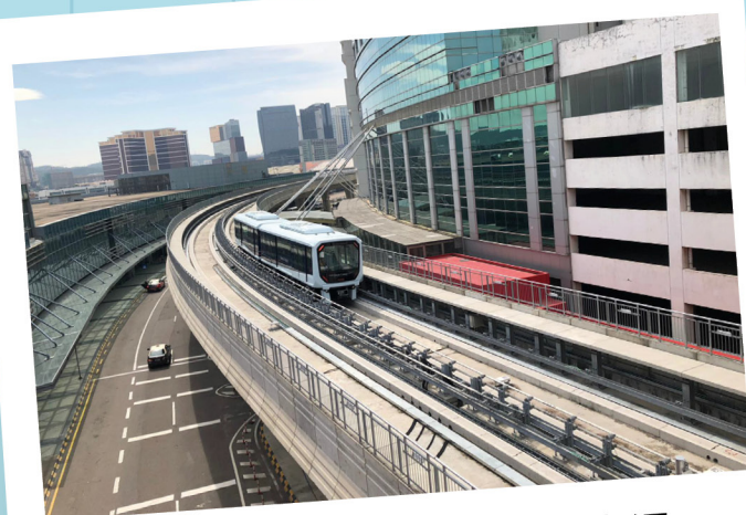
列車駛進機場站的測試實況
