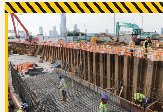
媽閣站主體建造工程臨時擋土牆施工
