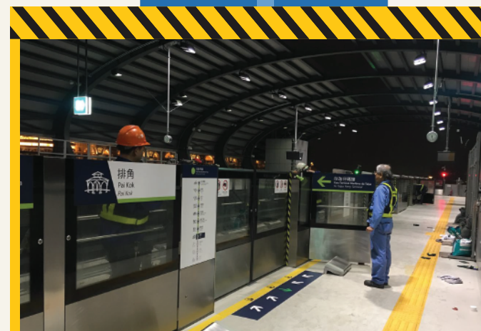
工作人員於車站進行標識安裝工作
