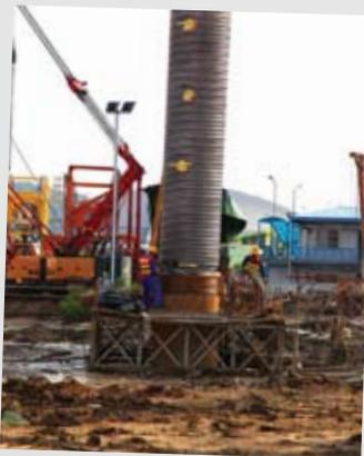
▲ 所有樁柱在灌漿前置入永久管套以防沉降。
