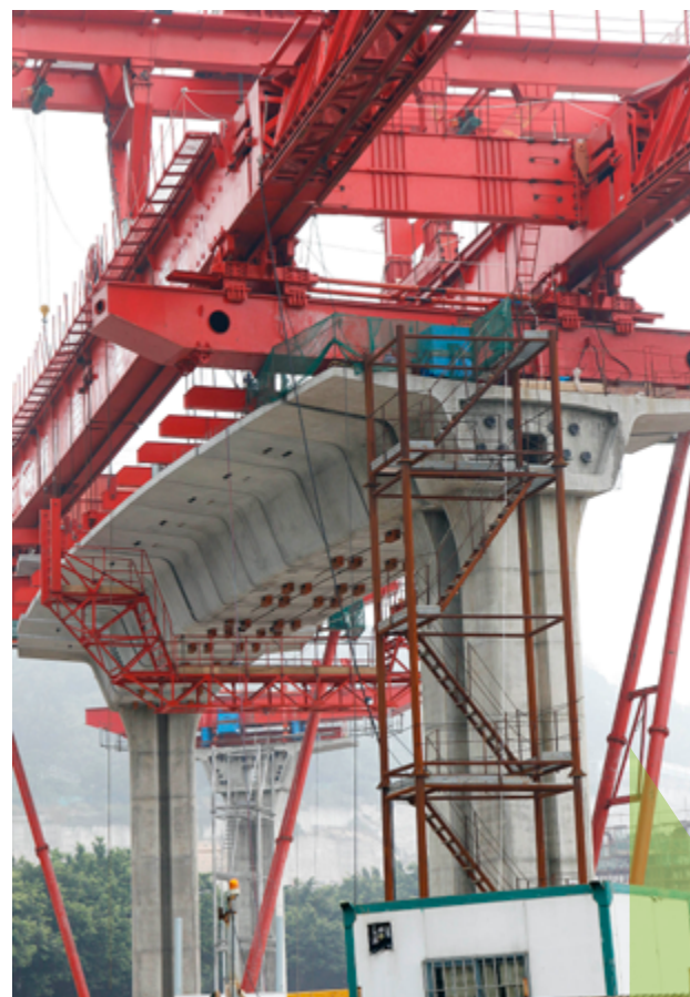
輕軌氹仔線第一跨高架橋橋面的預製件成功吊起
