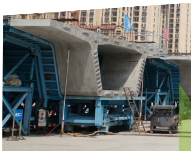
輕軌高架橋預製件正在多個廠房進行批量生產
