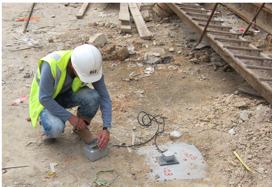
施工人員正在利用儀器在監測點讀取數據
