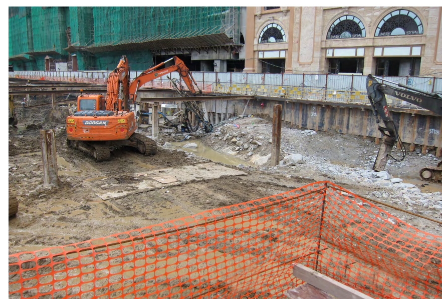
柯維納馬路交通樞紐開挖情況
