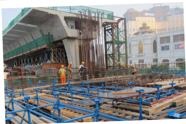
③ 施工人員展開排角站的建設工作
