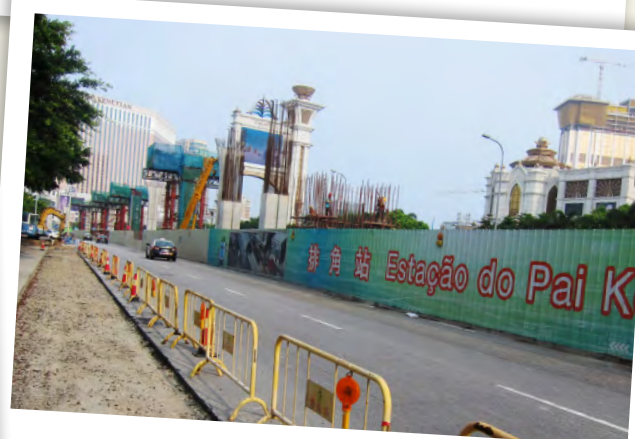
④ 開設臨時道路配合望德聖母灣大馬路排角站建設
