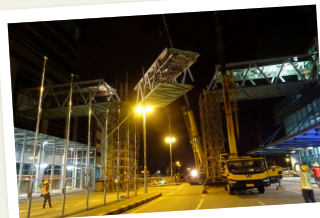
⑦ 為減低工程對交通的影響，施工單位在晚間進行拆卸行人天橋工程
