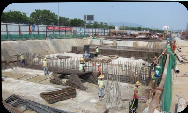
海洋站正進行地面板建設
