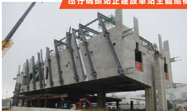
氹仔碼頭站正建設車站主體結構
