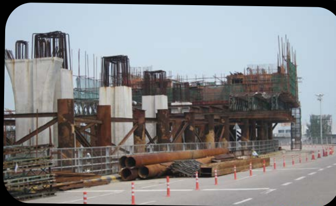
機場站橋墩大致完成，正準備開展車站建設工作
