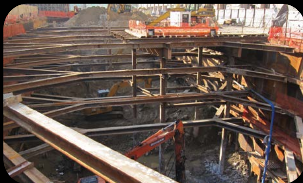
柯維納馬路開掘工程進行期間，四周以鋼樁組成穩固的擋土結構以確保施工安全
