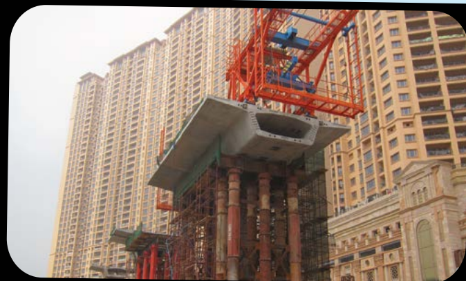
柯維納馬路現正進行平衡懸臂式吊裝高架橋面
