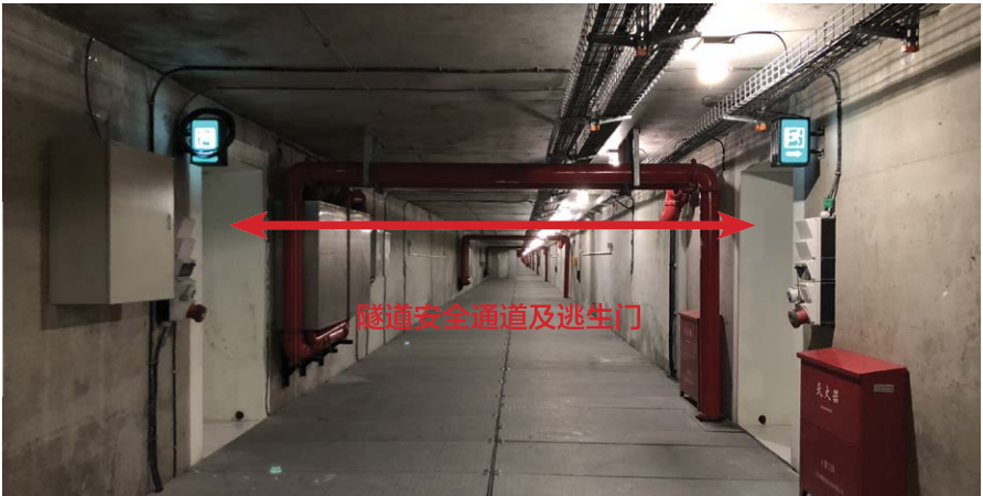
中央管廊逃生安全疏散通道及左右安全防火门
